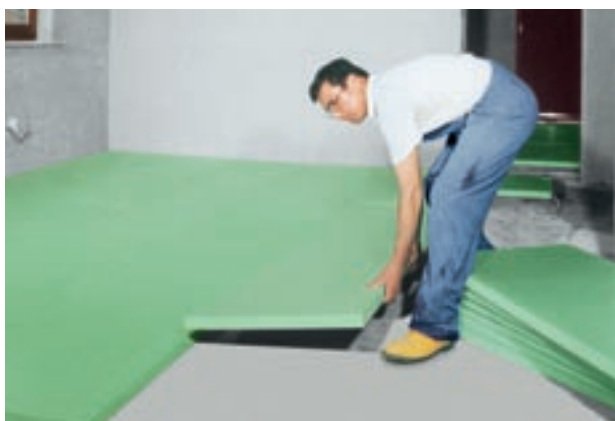
Abb. 19: Dämmung eines Kellerbodens.
