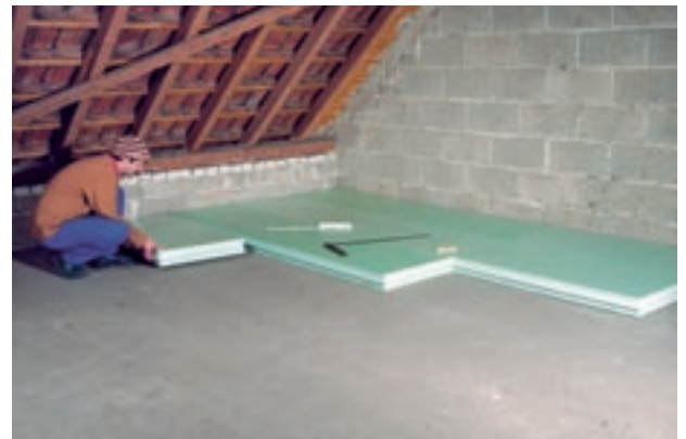
Abb.2: Dachbodendämmung mit Styrodur® C
