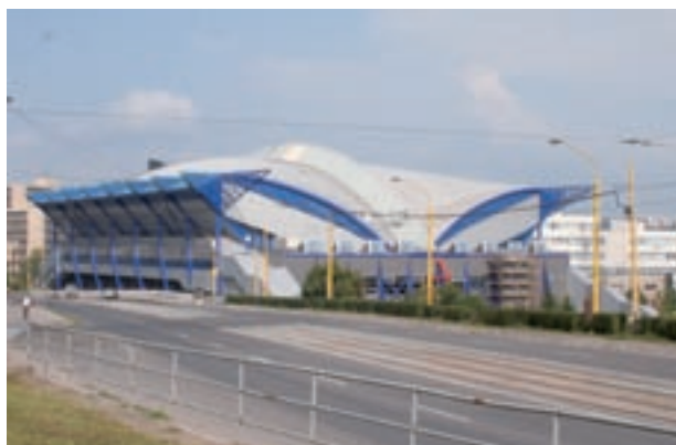
Abb. 17: Referenz: Steel Arena in Košice (Slowakei). In der neuen Eishockey-Halle wurde Styrodur® C unter der Eisfläche verlegt. Hier wird die Eishockey-Weltmeisterschaft 2011 stattfinden.
