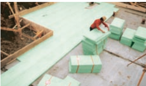
Abb. 4: Verlegung von Styrodur® C-Platten.
