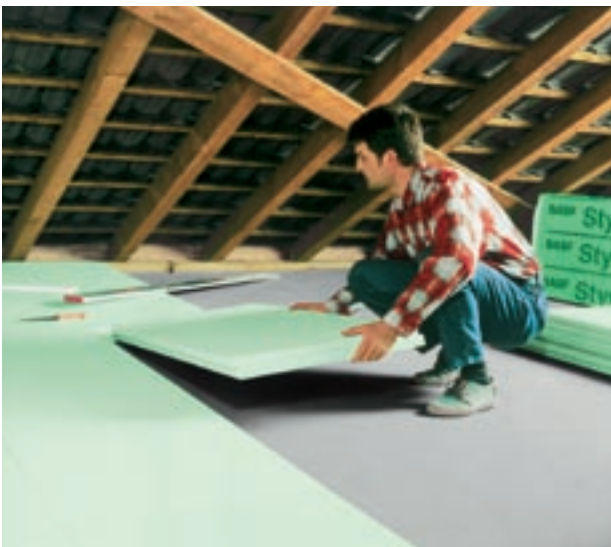
Abb. 10: Dämmung eines Dachraumes mit Styrodur® C.
