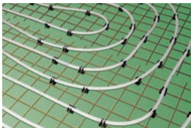
Abb. 21: Wärmedämmung mit Fußbodenheizung.
