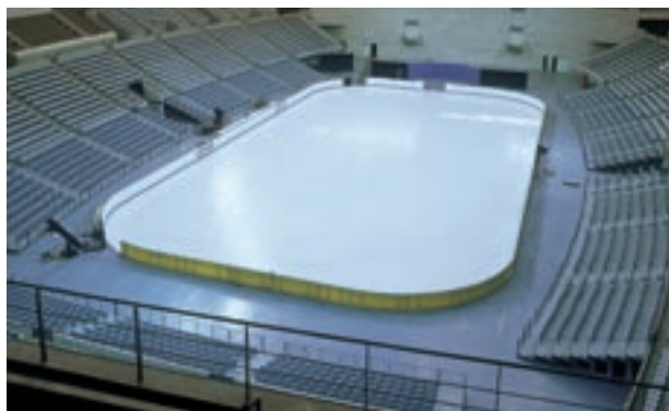
Abb. 16: Styrodur® C unter einer Eislauffläche.
