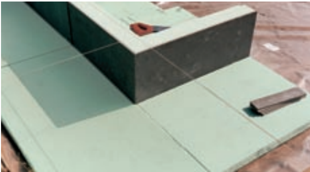
Abb.3: Dämmung einer Gründungsplatte mit Styrodur® C.
