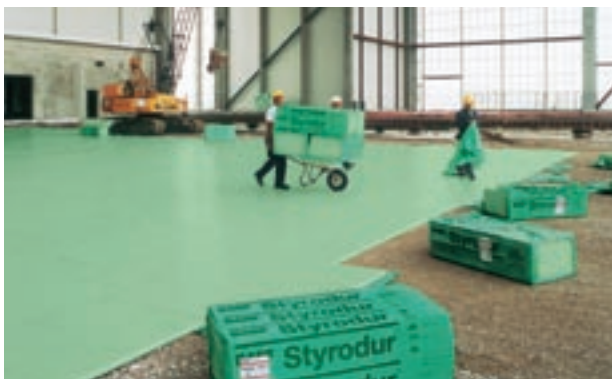
Abb. 23: Dämmung eines Hallenbodens mit Styrodur® C.
