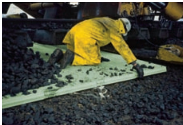
Abb. 9: Verlegung von Styrodur® C im Gleisbett.
