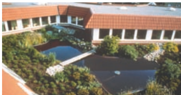
Abb. 6: Begrünte und begehbare Dachterrasse mit Anstaubewässerung in Folienteichen über einer Umkehrdachkonstruktion mit ganzflächiger Kiesdränschicht.
