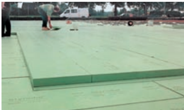
Abb. 29: Verlegung von Styrodur® C-Platten bei der Errichtung eines Passivhauses.
