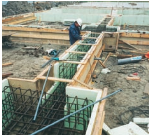
Abb. 15: Schalung mit Styrodur® C.
