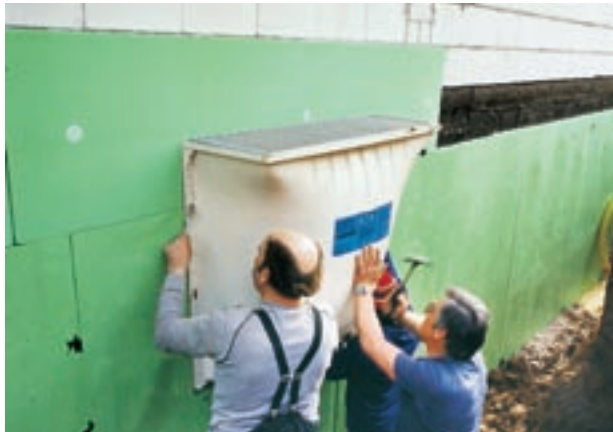
Abb. 3: Perimeterdämmung mit Styrodur® C.
