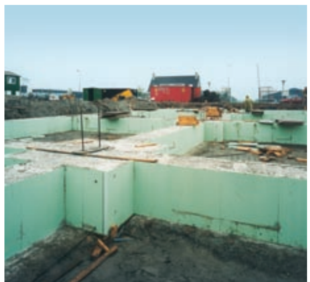
Abb. 16: In eine Schalung eingestellte Styrodur® C-Platten.
