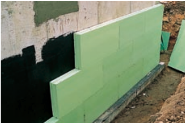
Abb. 5: Verlegung der Styrodur® C-Platten im Verband.
