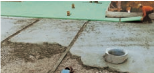
Abb. 18: Sauberkeitsschicht aus Magerbeton zur Verlegung der Bodendämmung.
