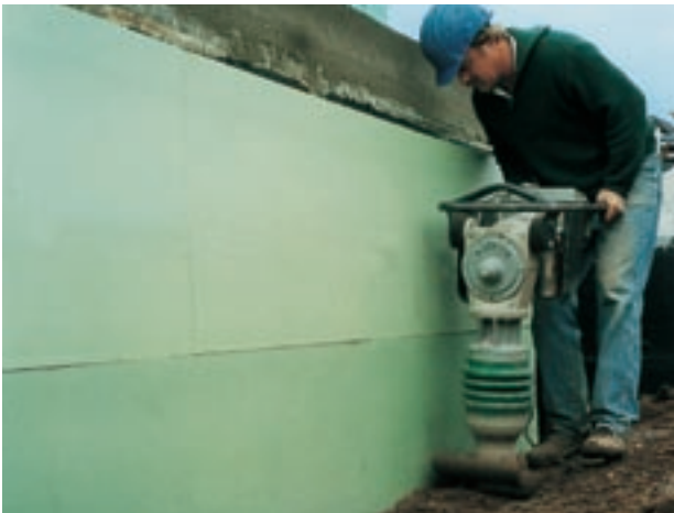
Abb. 26: Lagenweise Verfüllung der Baugrube und mechanische Verdichtung.
