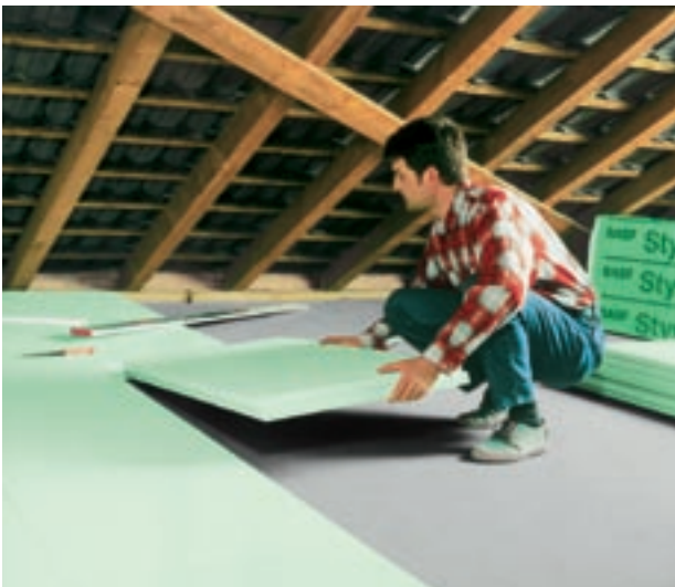
Abb. 4: Dämmung eines Dachraumes mit Styrodur® C.
