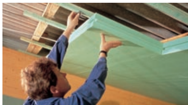
Abb. 7: Anbringung von Styrodur® C-Platten.
