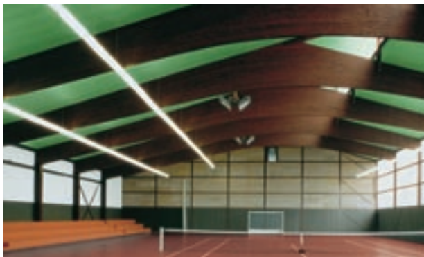
Abb. 1: Dämmung einer Sporthalle mit Styrodur® C.
