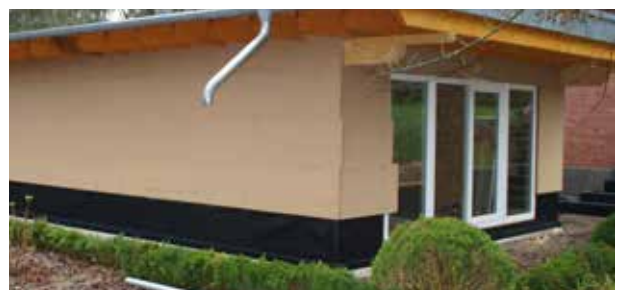
Abdichtung für Bodenplatte und Sockelbereich
