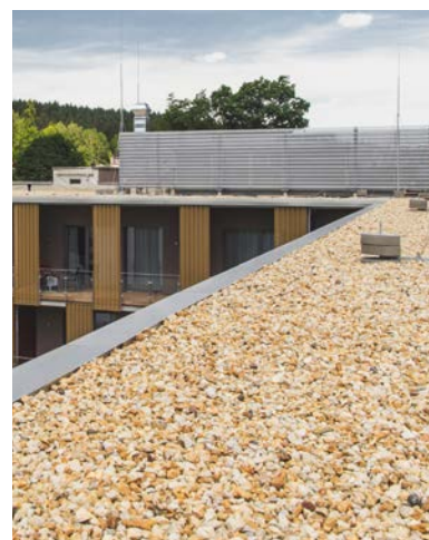
Verlegung unter Auflast
