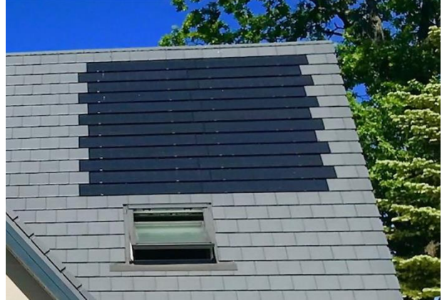
Puolen tiilen limitys.
