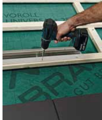
8.7 Montaż szyny startowej dla dachówki betonowej Tegalit/Teviva
